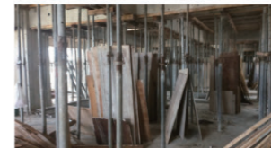
▲5階壁建て込み作業の様子
