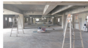
▲建物2階内装の様子
