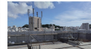
▲5階壁建て込み作業の様子 (6月末撮影)
